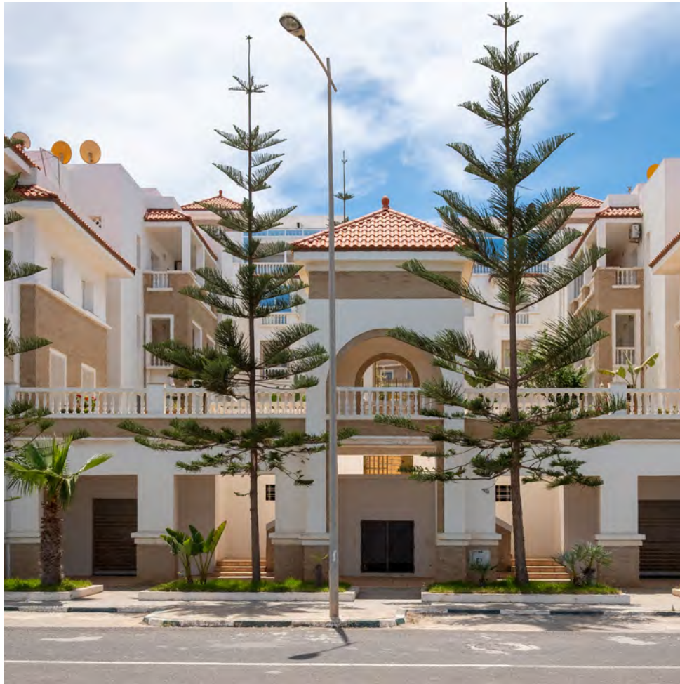
Ten westen van het centrum van Al Hoceima, boven de Corniche maritime de Sabadja, ligt een ruimer en luxer opgezet appartementencomplex – met per hof een eigen zwembad. Hier is meer aandacht en geld besteed aan de collectieve en openbare ruimte. In dezelfde wijk heeft Mohamed Cheik twee woongebouwen voor mensen met een handicap ontworpen.
