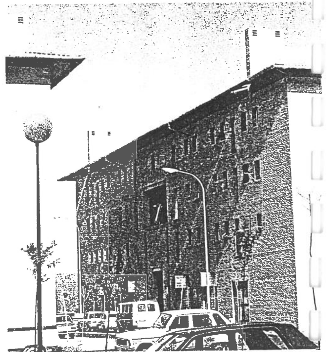
Aparejadores: Setafín Falla Moreno y Pedro Canavaya de Juan. 72 viviendas y locales comerciales. Empresa constructora: VICONSA, S.A. Proyecto: 1981. Construcción: 1982-83.
