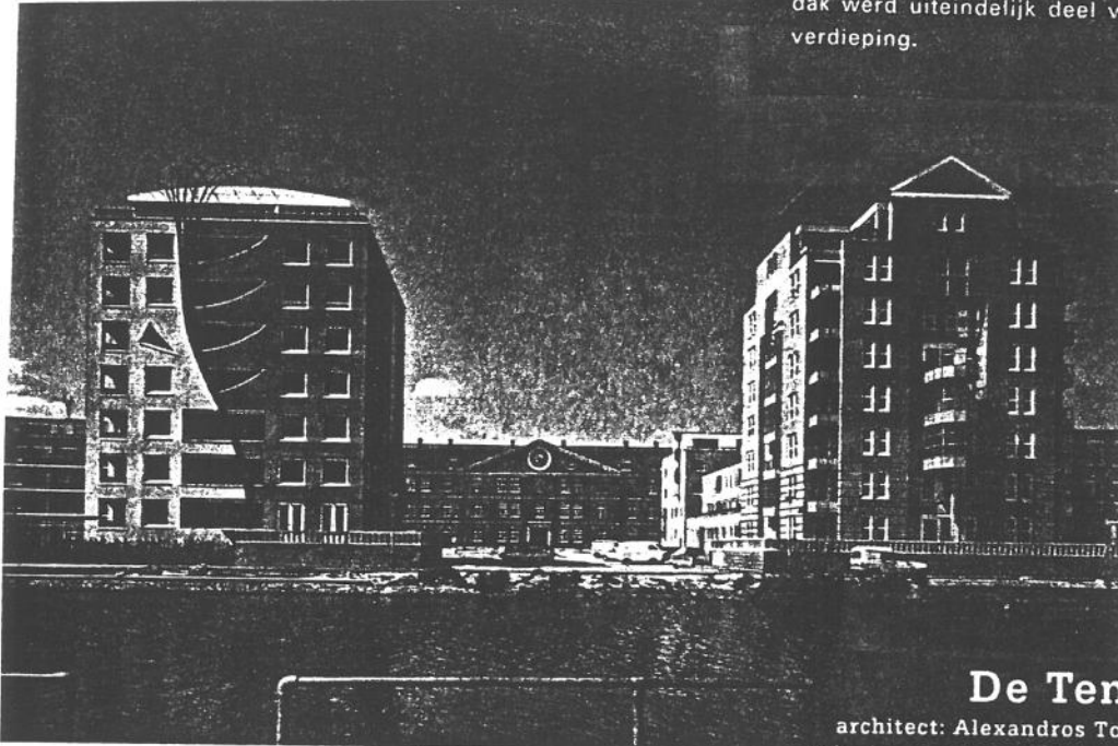
De centrale as van de kazerne wordt geflankeerd door de torens van Koji Yagi (links) en Alexandros Tombazis (rechts).
