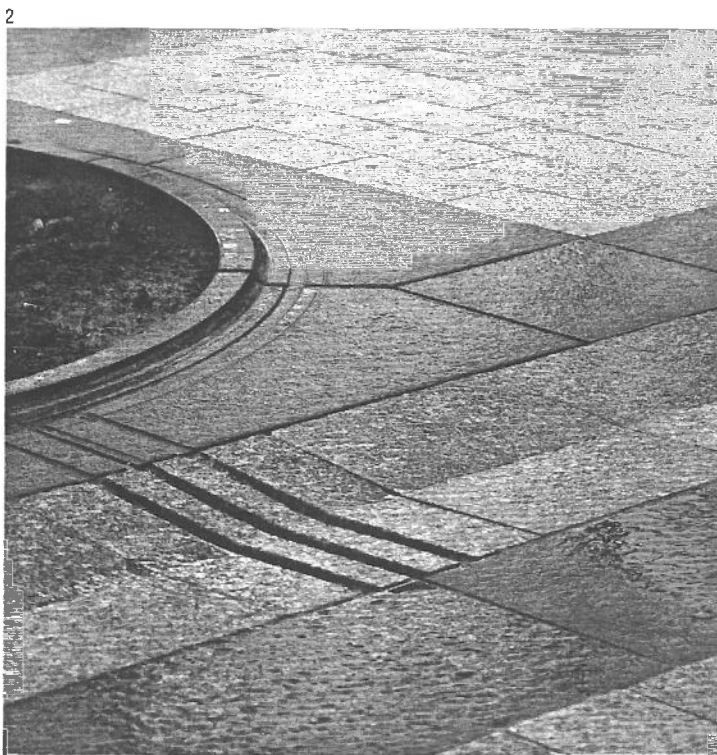
1, Pianta di una porzione tipica dell'Avenue des Champs-Élysées con dettaglio della pavimentazione sulle diverse zone funzionali. 2, Particolare della vasca per gli alberi (ancora priva della griglia di protezione) con cordolo sagomato di granito scuro, raccordato con la caditoia per la raccolta delle acque lungo i marciapiedi. 3, Disegno costruttivo della vasca per gli alberi e dettaglio di una caditoia. ■ 1, Plan of a typical portion of the Avenue des Champs-Élysées, with detail of paving on different functional zones. 2, Detail of tree tank still without protection grille with dark granite shaped kerbstone, connected to the water collection porticulis along the pavements. 3, Construction drawing of tree tank and detail of a porticulis.
