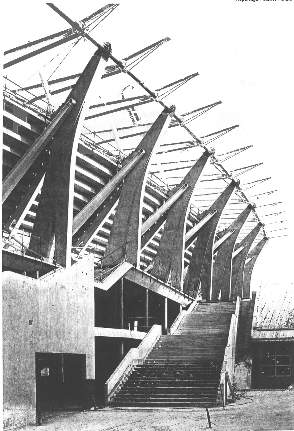
1 Les grandes tribunes en construction. 2 L'accès au stade à l'arrière des grandes tribunes. (Reportage Photo H. Abbadie)
