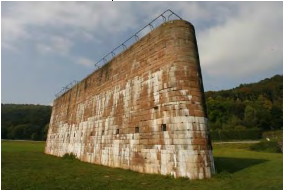
Foto: ddp Unfertige Brücken und Straßenüberführungen, die sinnlos in der Gegend herumstehen – in den unterfränkischen Wäldern gibt es insgesamt 47 Überreste einer von den Nationalsozialisten begonnenen Autobahn.
